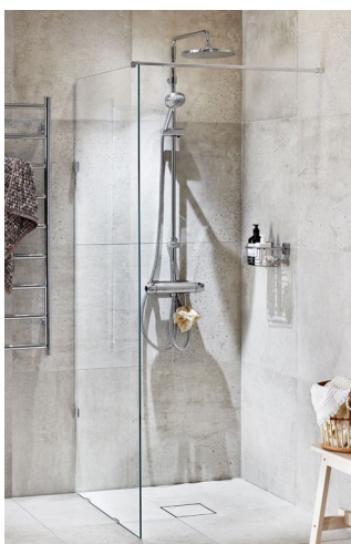
Montage mot vägg
